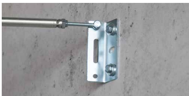
Befestigung von Wandhaltern und Konsolen
