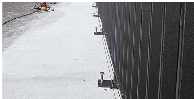
Montage von Hilfsstützen
