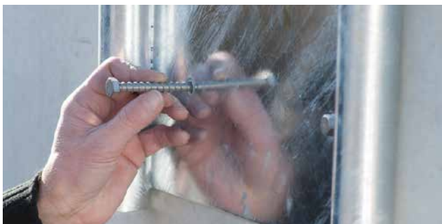
Stützen- und Rohrmontage
