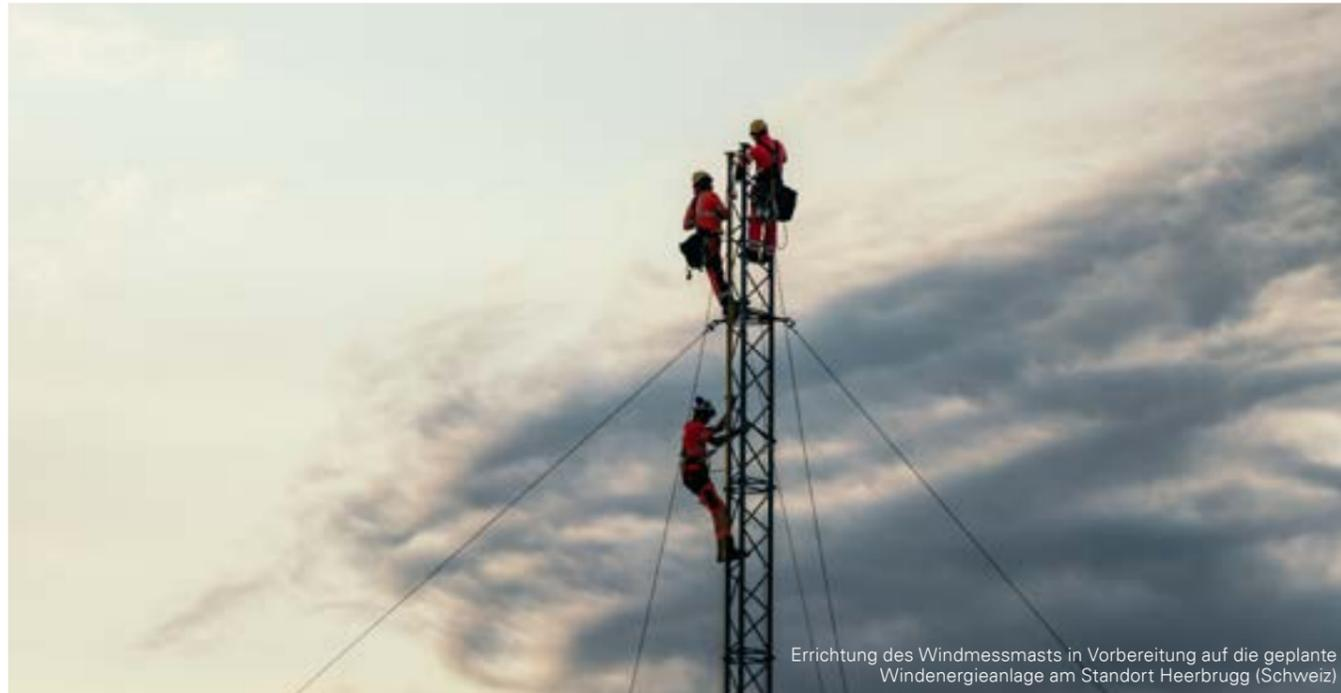
Errichtung des Windmessmasts in Vorbereitung auf die geplante Windenergieanlage am Standort Heerbrugg (Schweiz)
